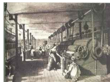
Instalações das máquinas têxteis
